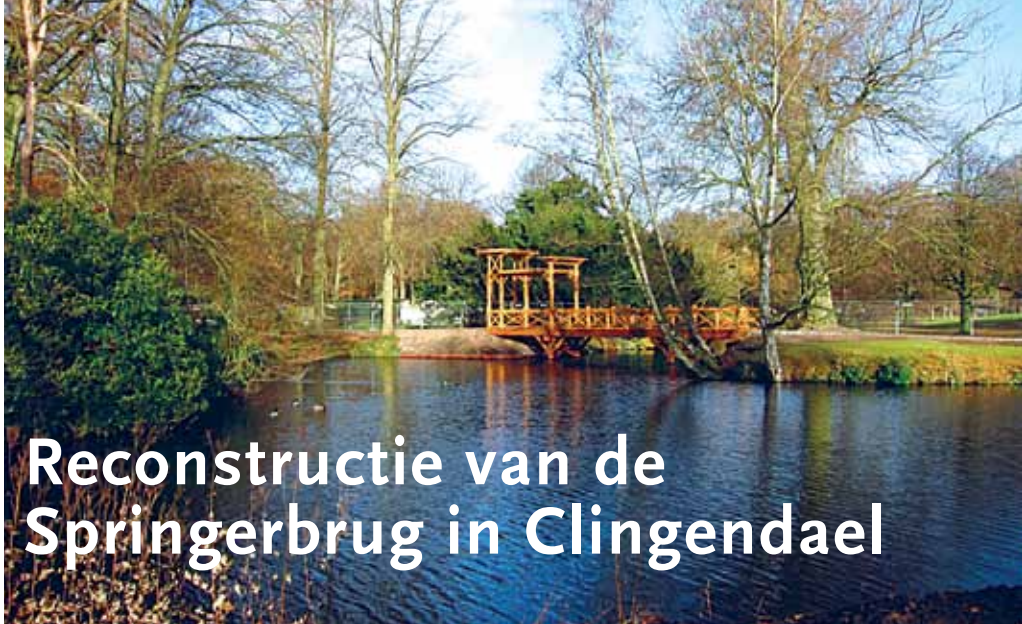
De gereconstrueerde Springerbrug.
