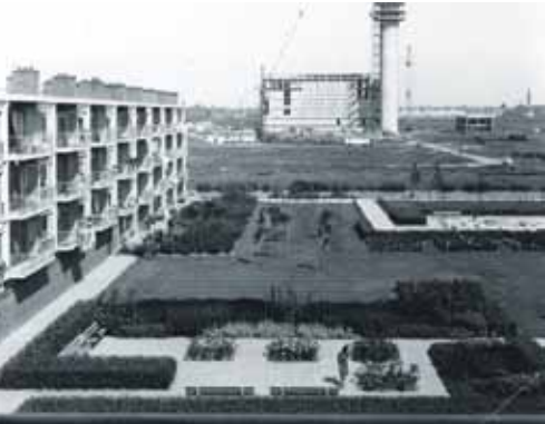
Hoofdkantoor Estel, Nijmegen 1976. Arch. A. Bodon.
