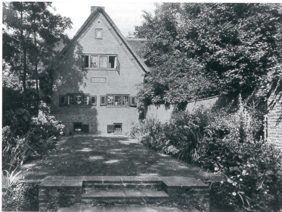
Landhuis te Wassenaar. Huis en tuin ontworpen door J.P. Fokker. ill. Het Eigen Huis, 1931, collectie Nederlands Architectuur Instituut.
