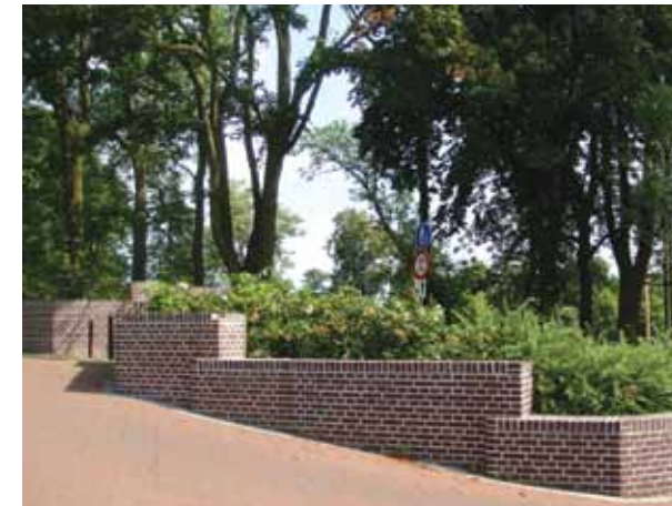
Eén van de twee vernieuwde hoofdingangen.
