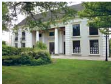
Buitenplaats 'de Sparrenheuvel' te Overveen, nu in gebruik als makelaarskantoor.
